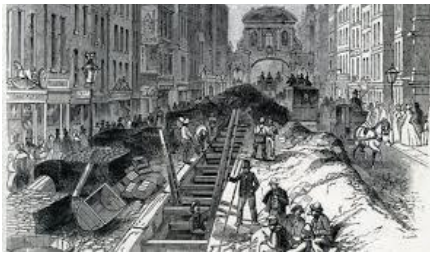
De aanleg van riolering in Londen
